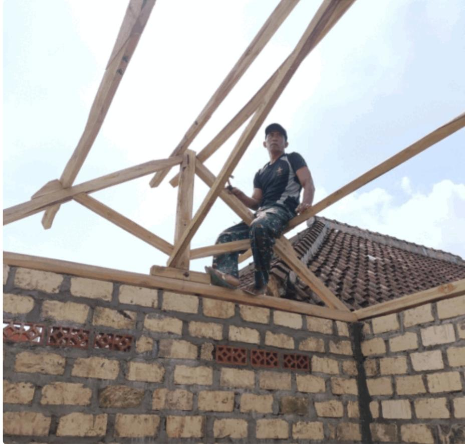
Dalam proses pembangunan rumah Bapak Irkhamni, memasuki tahapan pemasangan rangka atap dari bahan kayu jati.
